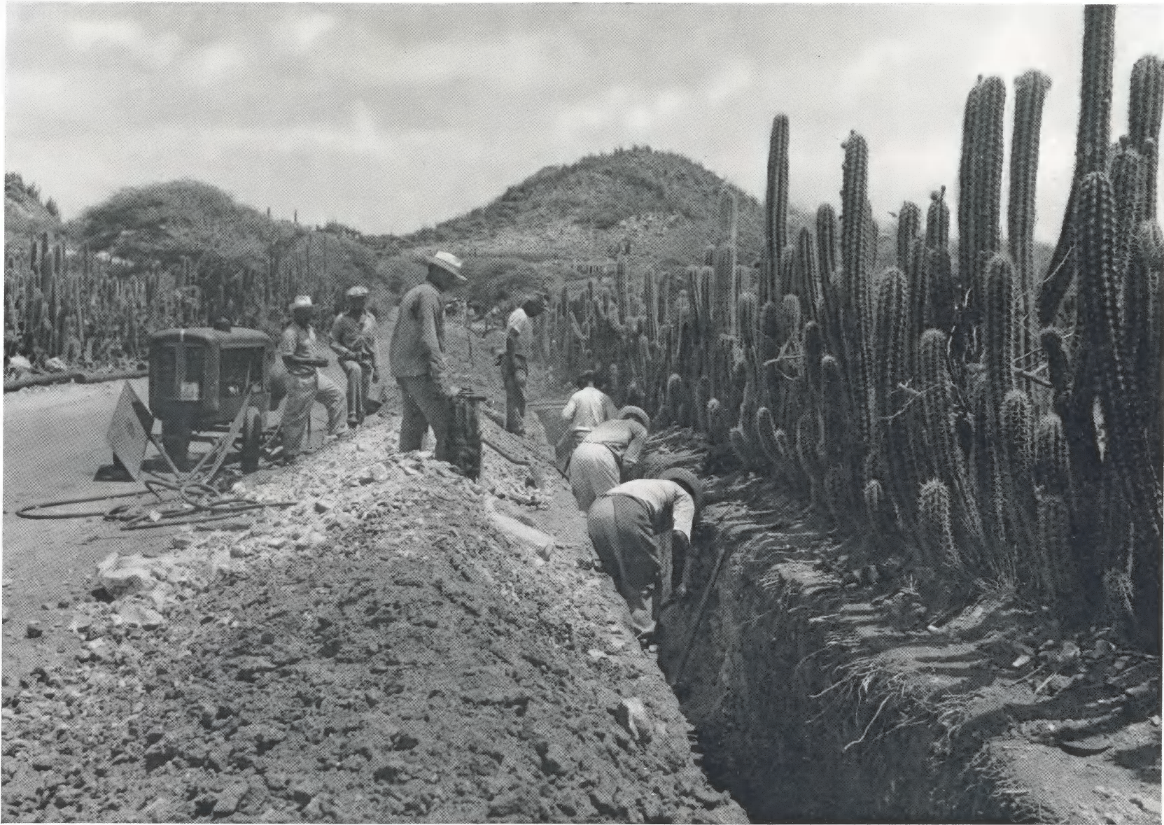
AANLEG HOOFDBUISLEIDINGEN PONEMENTO DI PIPA PRINCIPAL LAYING OF MAINPIPES
